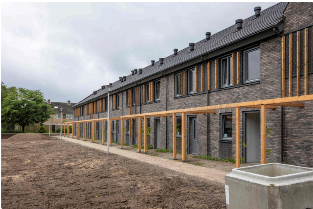
Project De Kaswachters, Zuidbroek Apeldoorn
